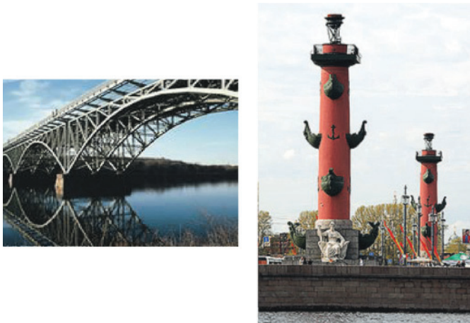
Рис. 3. Применение покрытий холодного отверждения
